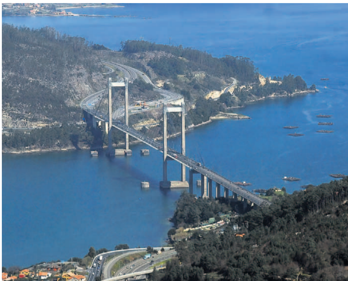
Vista aérea del puente de Rande, enseña de la ciudad. // Iñaki Abella
